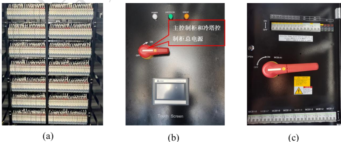
图 8-2 (a) 配电柜高算力服务器电源开关示意图 (b) 主控制柜内部示意图 (c) 配电柜总开关示意图
