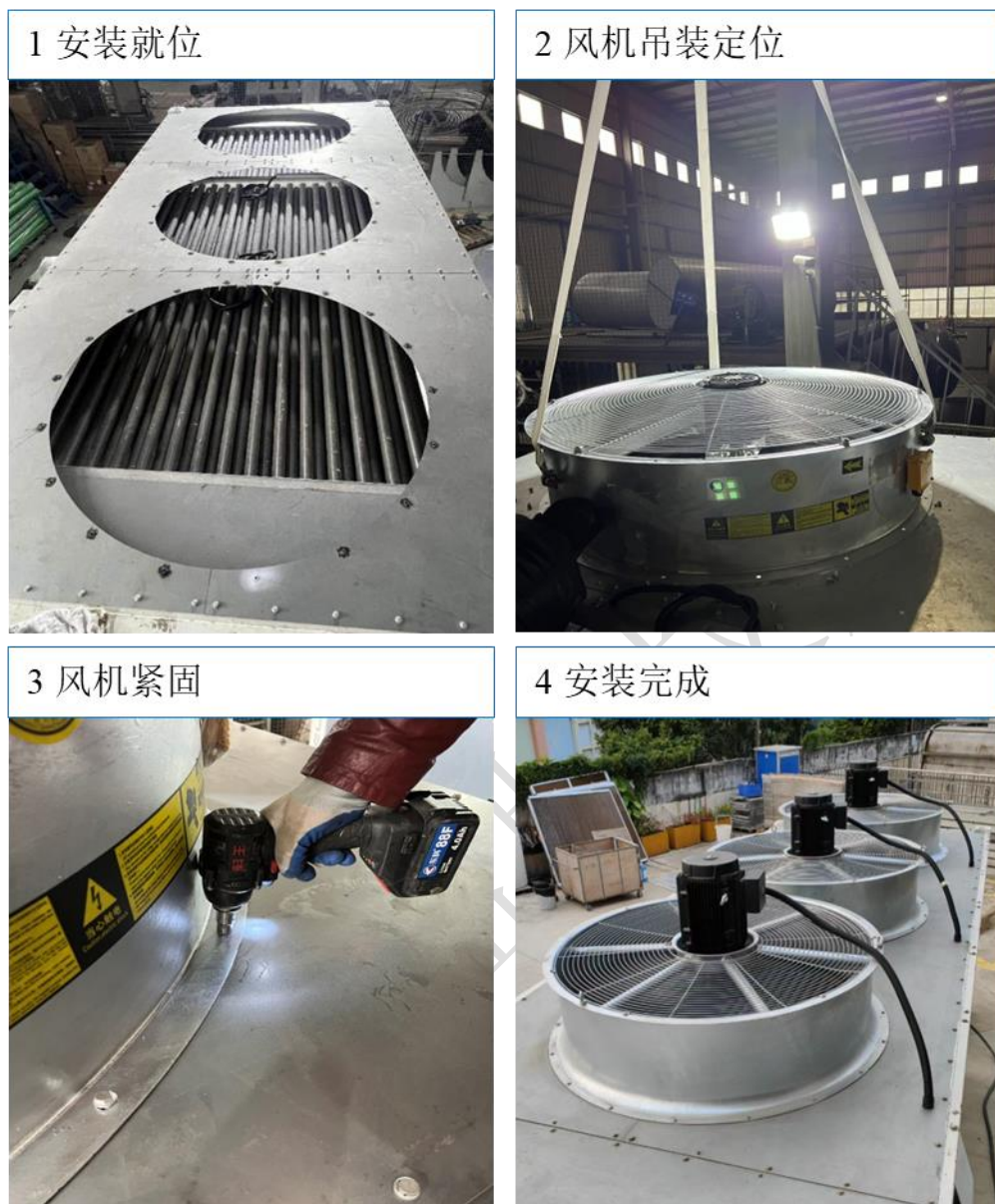
图 7-8 风机安装示意图
